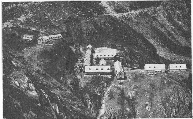
Fig. 2. — Chute de la Dixence : barraquements du Chargeur.
