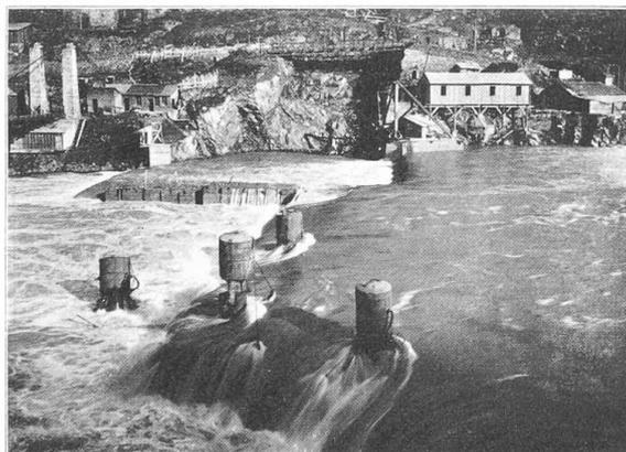
*Barrage de Pinet sur le Tarn.* Les sas des caissons pendant une crue de 800 m<sup>3</sup>, le 21 décembre 1927. (Cliché «Energie électrique du Rouergue S. A.».)
