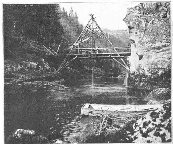
*Barrage de Chatclot sur le Doubs.* Recherche par forage dans la rivière. (Cliché M. Lugeon.)
