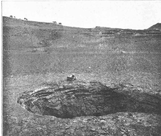
*Retenue de Monte-Jaque. Ouverture soudaine sur le fond de la retenue après quelques jours de remplissage. La perte s'est fait jour à travers de l'argile recouvrant directement le calcaire fissuré. (Cliché M. Lugeon)*
