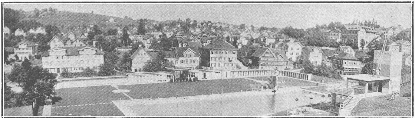
Fig. 7. — Piscine de Heiden. Vue générale.
