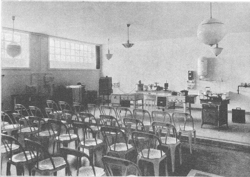
Fig. 7. — Salle de démonstration. Podium avec chauffe-eau au-dessus de l'évier, grils d'hôtel et mur nu pour projections lumineuses.
