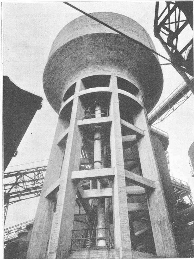
Fig. 11. — Château d'eau, d'une capacité de 1000 m<sup>3</sup>, de la Société des Forges de Clabeceq.
