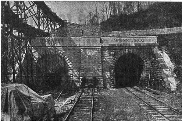
C. F. F. Tunnel du Ceneri, portail sud.
