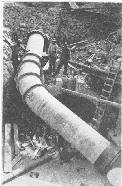
Fig. 27. — Coude de la conduite forcée, à l'entrée de la galerie de la Drance.
