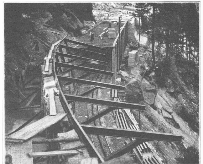
Fig. 1. — A Täschwand (km. 31,7 environ). De la galerie de protection à colonnes, on passe à la galerie sous consoles métalliques ancrées dans des massifs contre-poids en béton.
