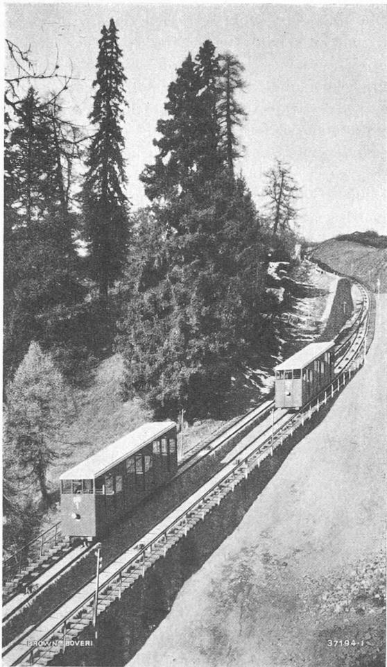
Fig. 2. — Evitement de la section inférieure.
