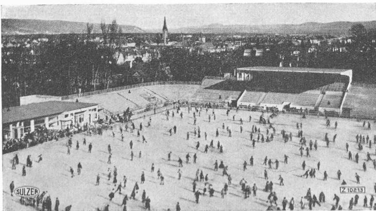
Fig. 1. — Patinoire artificielle, en plein air, de la ville de Bâle, équipée d'une installation frigorifique Sulzer comportant deux compresseurs d'ammoniac de 500 000 frig/h chacun.
