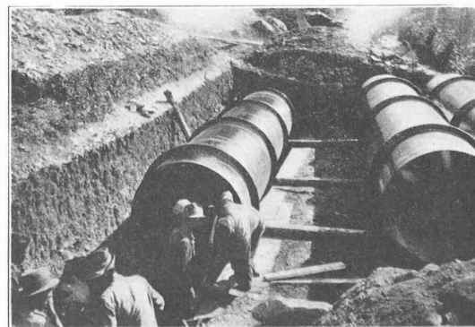
Fig. 17. — Chargement des tuyaux de Saleinaz.
