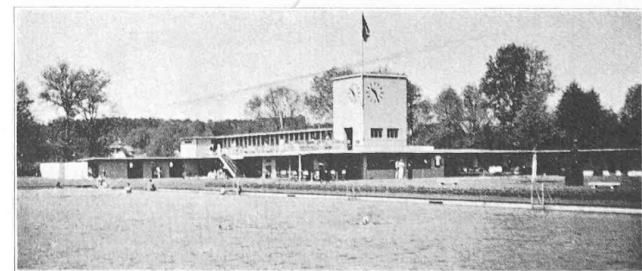
Fig. 1. — Vue générale de la piscine de Langenthal.
