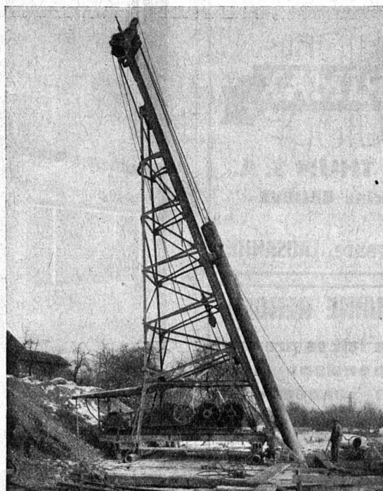
Sonnette Franki en position pour pieux inclinés.
