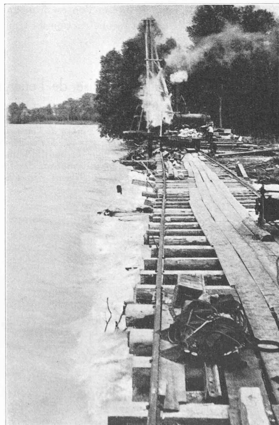
Fig. 4. — Pont de service et battage (marteau Pajot) du rideau principal de palplanches.
