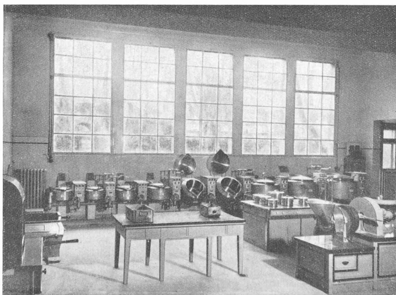
Cuisine électrique de l'asile de Préfargier.
