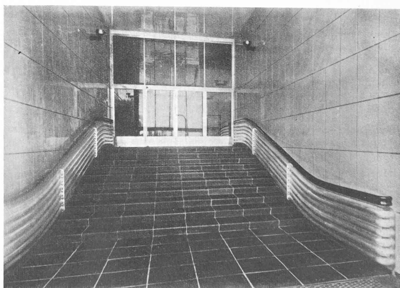
Fig. 2. — Rampes d'escalier à l'Ecole polytechnique fédérale. La rampe est constituée par les tuyaux en aluman du chauffage central.
