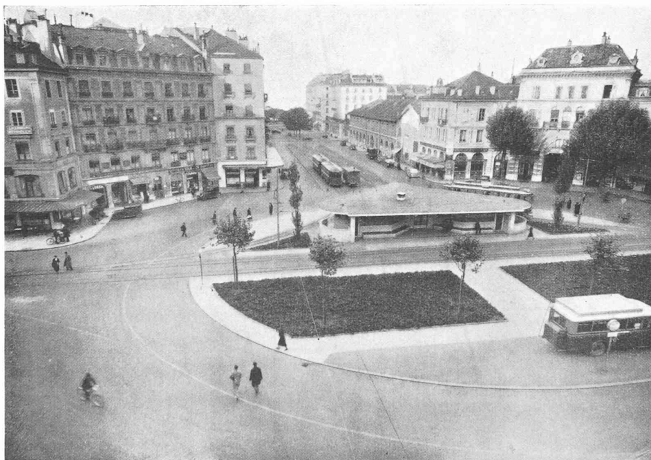
Fig. 7. Carrefour de Rive. Postérieurement aux travaux.
