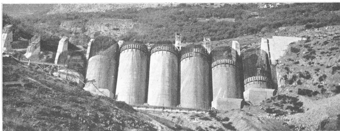
Fig. 3. — Elévation amont. Vue du barrage plein, à l'aile droite.
