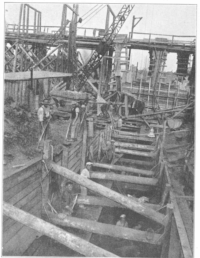
Fig. 12. — Fouille blindée du mur de rive droite amont. Photo Dyckerhoff & Widmann (Berlin).
