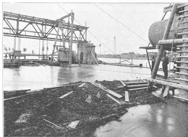
Fig. 20. — Fouille du seuil 4 inondée lors d'une crue du Rhin.
