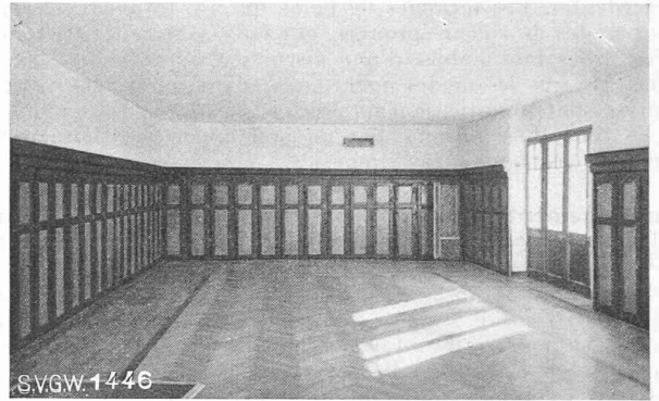
Fig. 9. — Salle de jeux de l'Institut Beau-Soleil, à Villars s/Ollon. Bouche de soufflage dans la paroi du fond. Bouche de reprise dans l'armoire ouverte.
