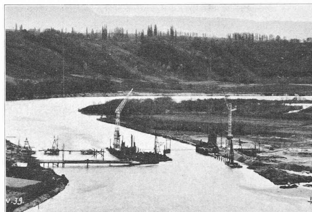
Fig. 14. — Vue du chantier de l'usine-barrage, prise de l'amont, en avril 1939. Construction du batardeau de la pile III et du premier batardeau de la rive droite.
