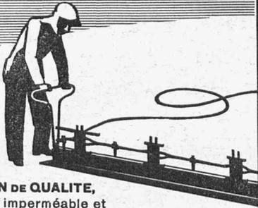
**BETON VIBRE = BETON DE QUALITE**, homogène, compact, imperméable et de grande résistance.
