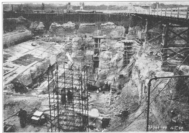
Fig. 2. — Chantier de l'usine (fondations des groupes 1 et 2) à l'intérieur du batardeau rive droite, en février 1940.
