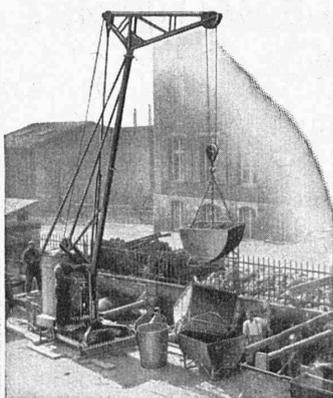
Tous les arbres d'engrenage de la petite grue RACO tournent dans des roulements à billes de précision et ne sont, de ce fait, soumis pratiquement à aucune usure. Le treuil et le moteur, montés dans une cabine de protection fermant à clef, sont d'un accès facile. Tout recul de la charge est rendu impossible par l'action de cliquets de sûreté et un frein à contre-poids. Un câble antigiratoire sert d'organe de levage et la poulie à câble peut servir pour l'élévation directe ou mouflée.
