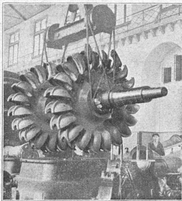
Roues Pelton des Turbines de 15 000 CV Usine Amsteg des CFF
