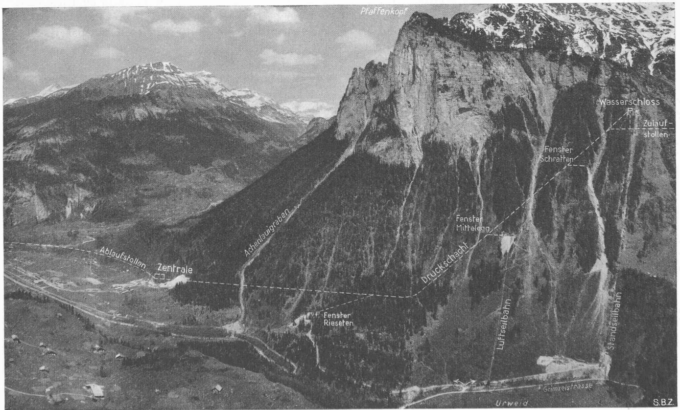
Fig. 5 — Vue d'ensemble des installations.
