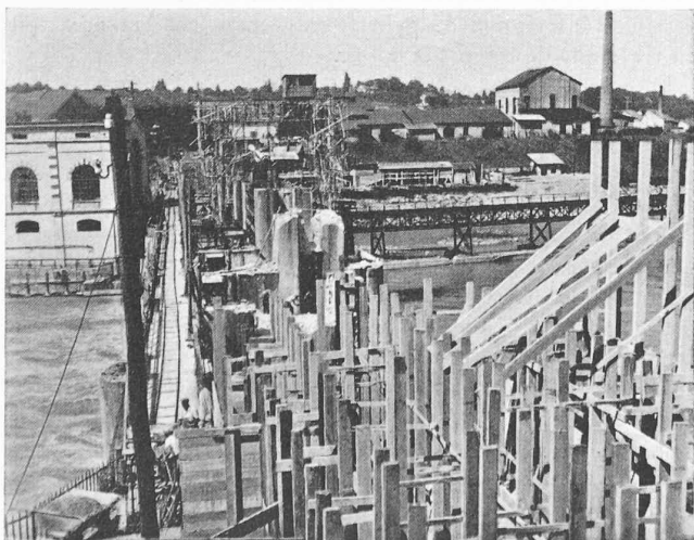
Fig. 2. — Etat du chantier en juillet 1943 ; à gauche, la passerelle construite en 1905.
