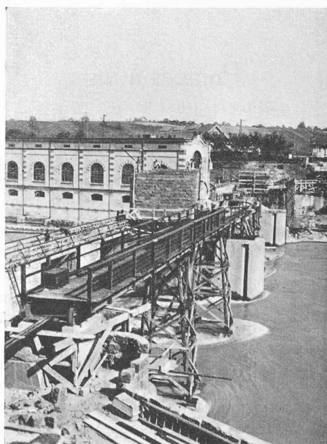
Fig. 5. — Passerelle provisoire au montage (tronçon rive gauche).
