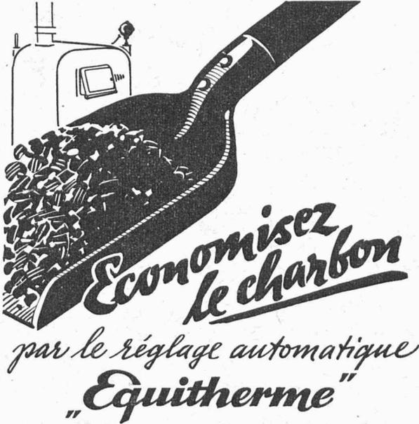
Le réglage «Equitherme» est assuré par des appareils automatiques très simples, réglant la température de la chaudière en fonction des conditions atmosphériques au moyen d'une sonde placée à l'extérieur. Il maintient la température des locaux constante en réalisant une économie continue de combustible sans surveillance aucune.
