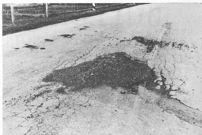
Fig. 2. — Type de chaussée munie d'un revêtement bitumineux et fondée sur sol glaiseux-sableux, détruite par le gel de l'hiver 1941-1942.
