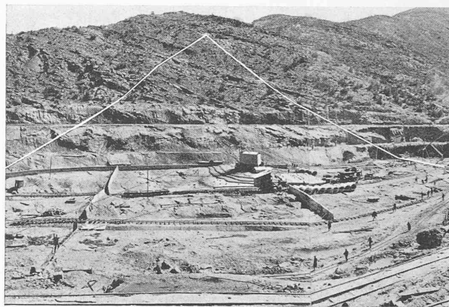
Fig. 11. — Les terrains de fondation avec l'emprise du barrage et les premiers éléments du filtre : drains et murettes.
