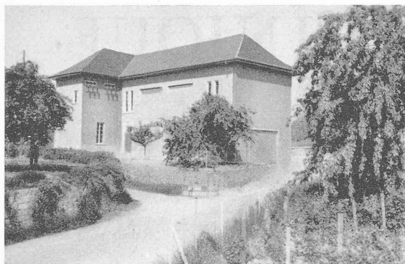
Fig. 2. — Poste de Marcelin. Vue générale de l'est.
