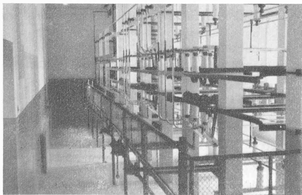
Fig. 10. — Sectionneurs et barres 13 kv.
