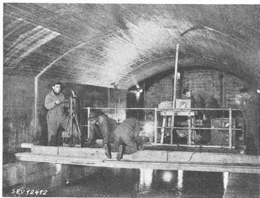
Fig. 4. — Chambre de jaugeage pendant l'exécution des mesures.
