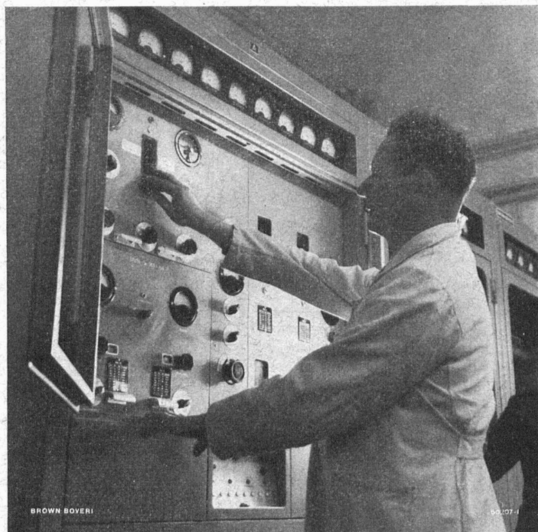
Accord d'un émetteur à ondes courtes
