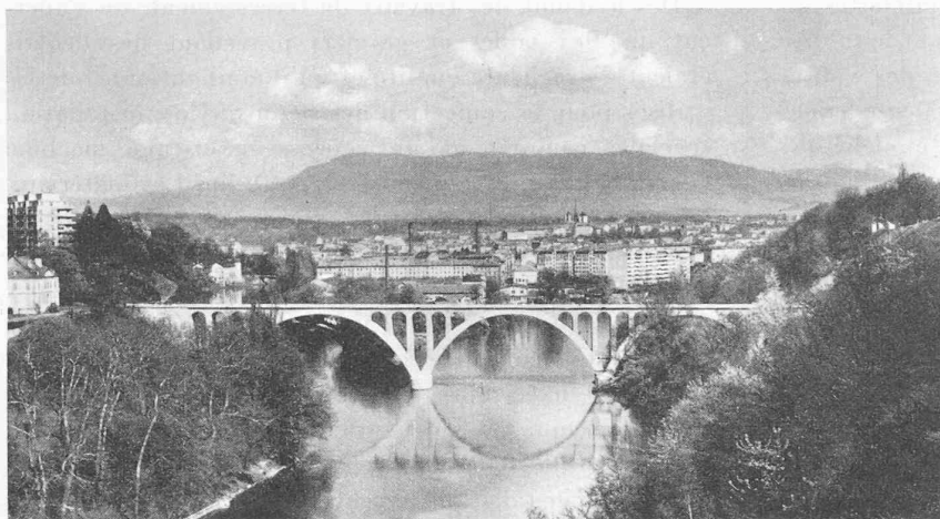
Fig. 2. — Le pont achevé. Avril 1946.
