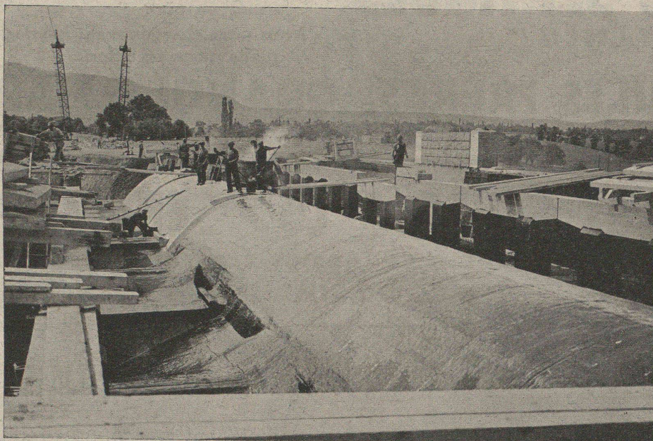
Revêtement étanche sur route de pont.
