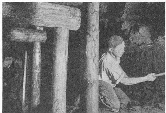
Fig. 11. — Dépilage des longs piliers.
