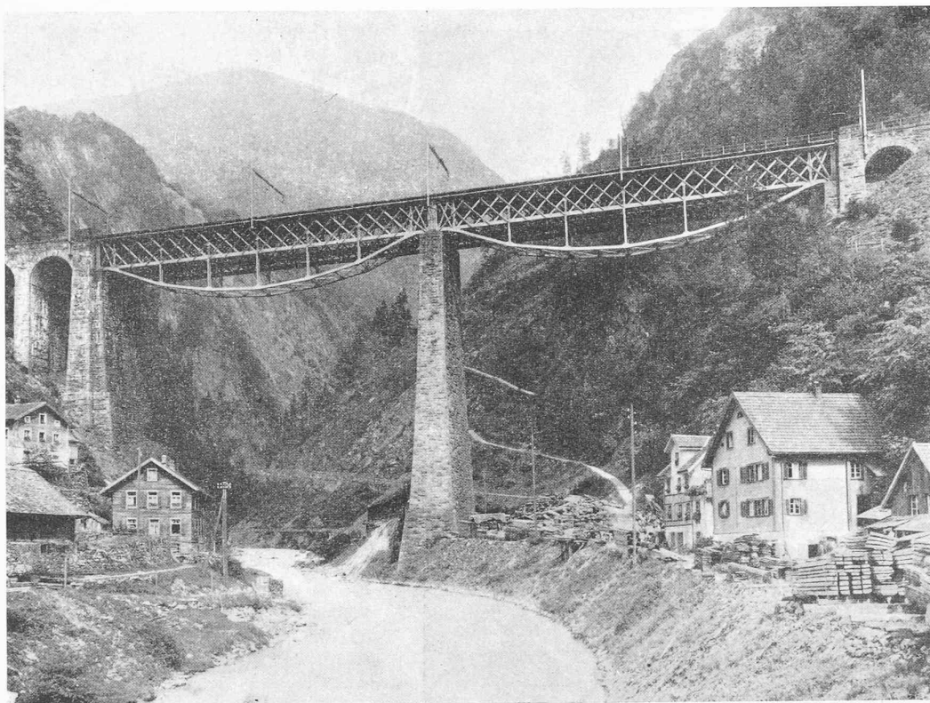
Fig. 4. Pont du Kerstellenbach, rampe nord du Gotthard. 2 travées de 50 m. Ren- forcement par sous-tirant.
