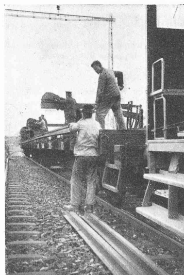
Fig. 5. — Grues Robel pour manutention des longs rails.
