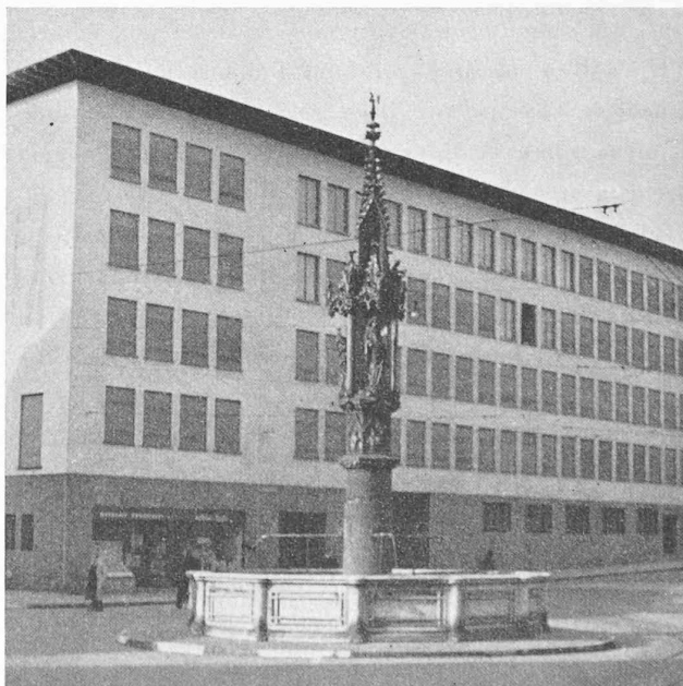
Fig. 24. — Une architecture régulière peut mettre en valeur un monument ancien ; vieille fontaine gothique à Bâle.
