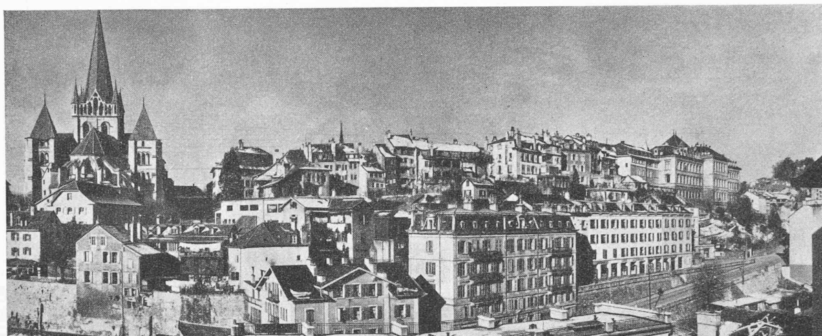
Fig. 12. — Aspect désordonné du couronnement de la Cité, vue de la rue Caroline (façades est de la rue Cité-derrrière).
