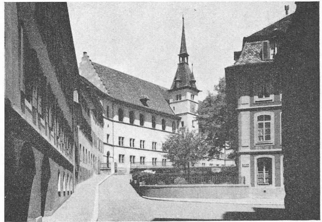
Fig. 6. — Place de la Cathédrale (nord) après démolition.
