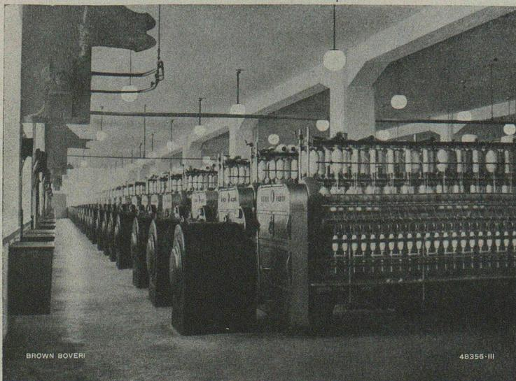
Continus à filer à commande à vitesse réglable par moteurs à collecteur à caractéristique shunt avec variateur automatique.
