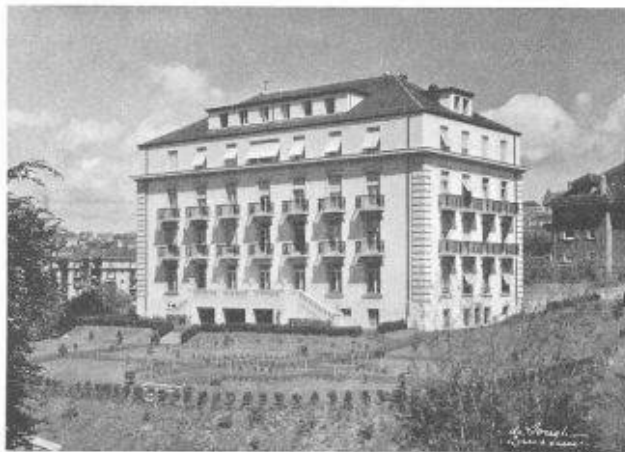
Fig. 39. — Clinique Montchoisi, Lausanne. Ch. Andrien, architecte S. I. A., Lausanne.
