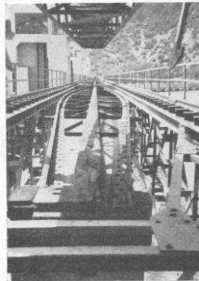
Fig. 6. — Elément de batardeau en réserve.
