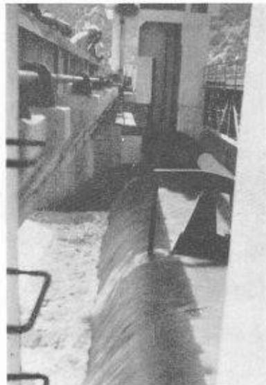
Fig. 5. — Déversement sur la hausse abaissée.
