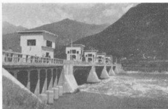
Fig. 7. — Le barrage, vue d'aval.
