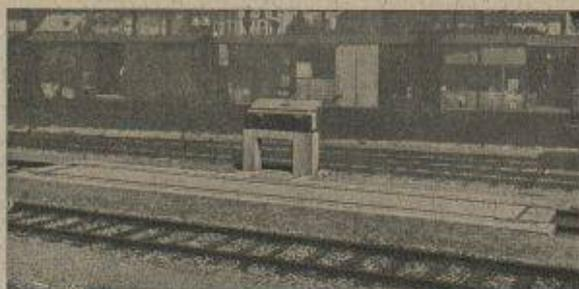
Pont à bascule pour chemins de fer. Capacité de pesage de 70 tonnes. Type normal des CFF avec pont en béton à nervures, longueur 11,6 m, construction Giroud, permettant le passage de locomotives d'un poids de 120 tonnes.
