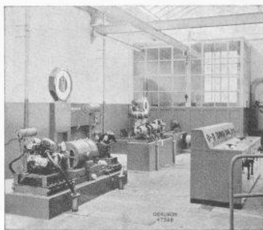
Fig. 2. — Dynamomètres électrodynamiques installés dans une fabrique de moteurs à essence.
