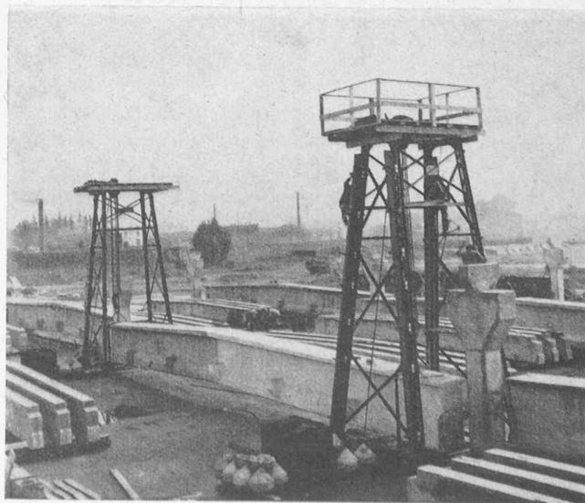
Fig. 11. — Usine textile à Gand. Vue générale du chantier de fabrication des poutres principales et secondaires. Chevalet de montage pour les poutres principales.
