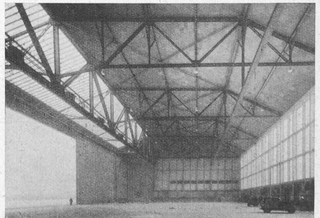
Fig. 25. — Vue intérieure de la halle de montage.
