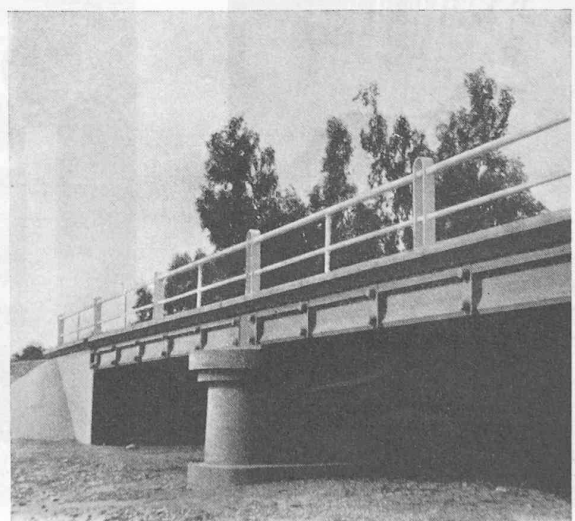
Fig. 20. — Pont sur l'Oued Saad en Tunisie, comprenant deux travées constituées par des poutres de 10 m jointives.
