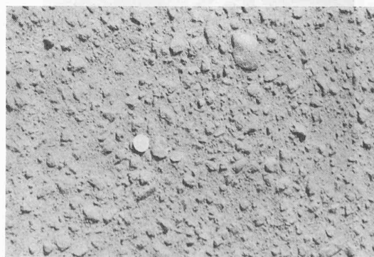
Fig. 8. — IDAHO SPRINGS, Idaho. Tapis de mortier bitumineux des routes US 6 et US 40, extrêmement rugueux. La pièce de monnaie au centre de la figure a un diamètre de 24 mm.
