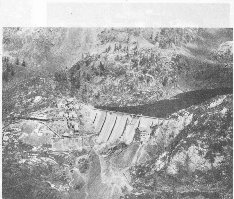
Fig. 13. — Vue générale sur le barrage et le lac de Trona.
