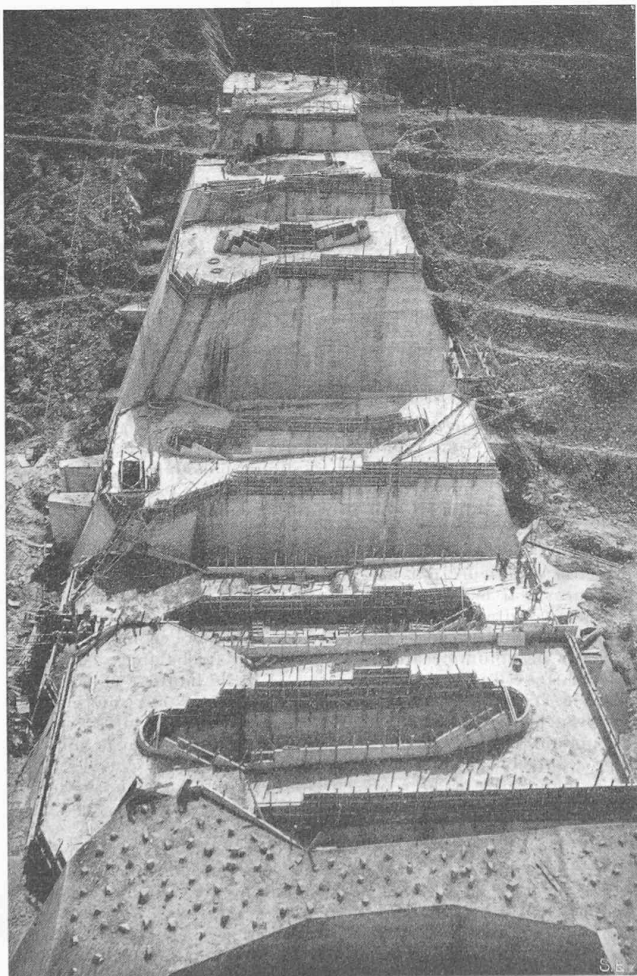
Fig. 20. — Barrage de Bau Muggeris au cours des travaux (septembre 1948).
